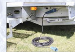
Stromanschluss 230 V / 16 A mit Verlängerungskabel
