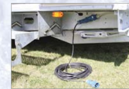
Stromanschluss 230 V / 16 A mit Verlängerungskabel
